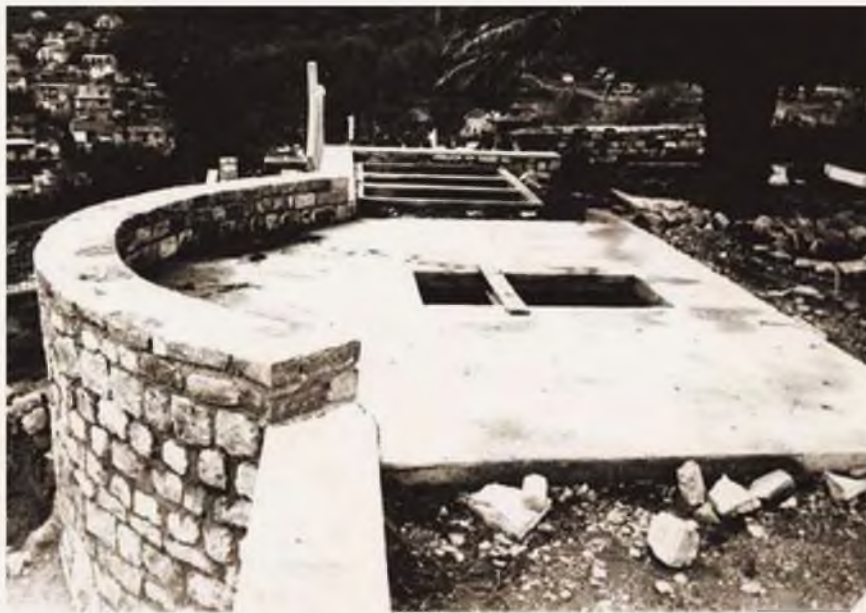
Изглед основе новоизграђене крстице са отвором и три бетонске гробне раке
