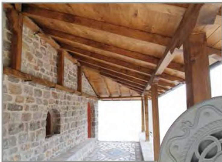
Детаљ дрвене конструкције шрема
