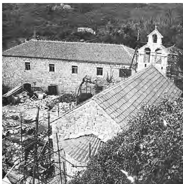
Manastir Gradište pri kraju obnove
