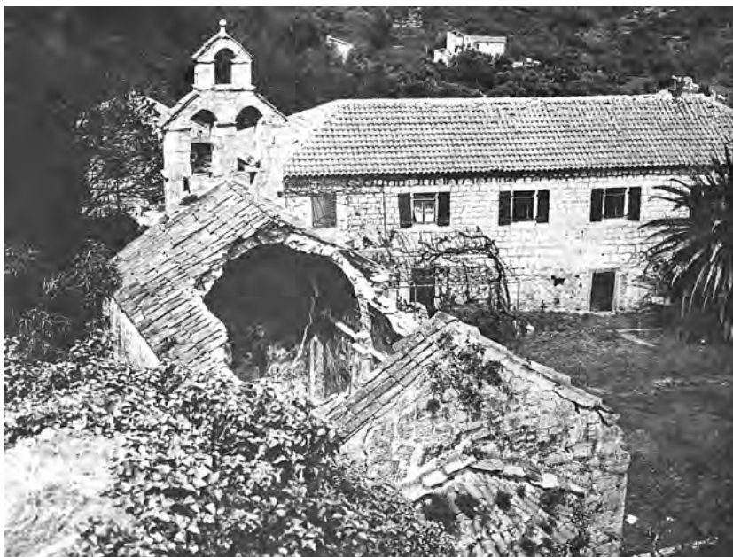
Manastir Gradište prije obnove
